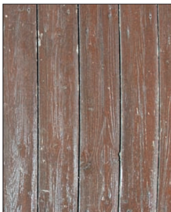
Stare podłogi drewniane
