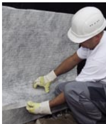
Klejenie płyty ochronno-drenażowej BOTAZIT® DS 993
