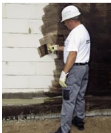
Gruntowanie podłoża przy użyciu BOTAZIT® BE 901
