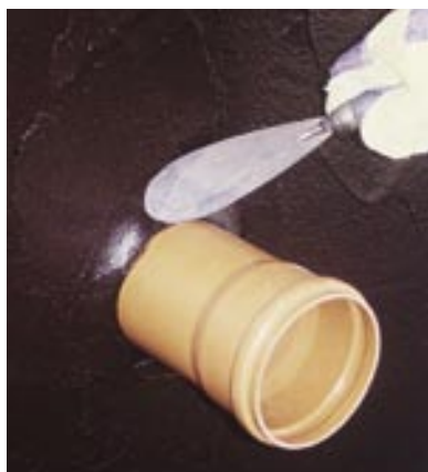
Wykonanie wyokrąglenia w miejscu przechodzenia rur
