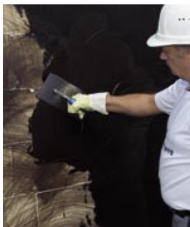
Nakładanie bitumicznej izolacji grubowarstwowej z BOTAZIT® BM 92 Schnell/Winter, BM1
