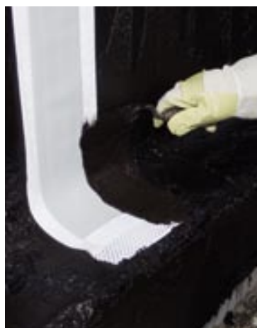
Wtapienie taśmy uszczelniającej BOTAZIT® B 180
