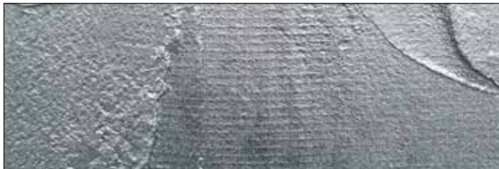
➤ Stare grubowarstwowe izolacje bitumiczne
