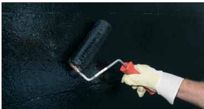
• Gruntowanie podłoża przy zastosowaniu BOTAZIT® B 97 L
