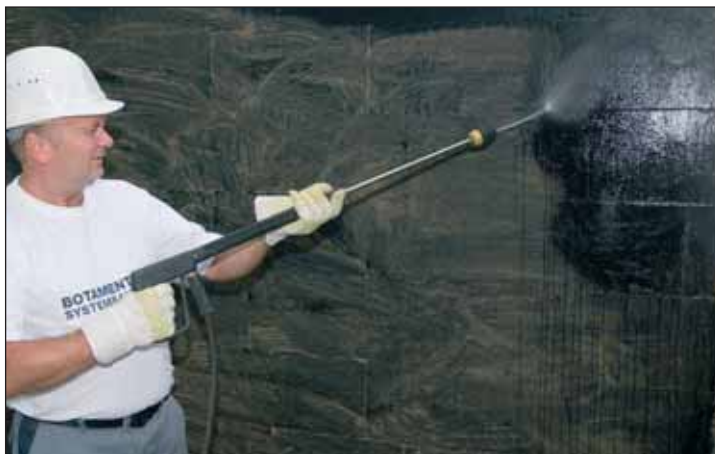
➤ Czyszczenie podłoża przy zastosowaniu urządzenia wysokociśnieniowego
