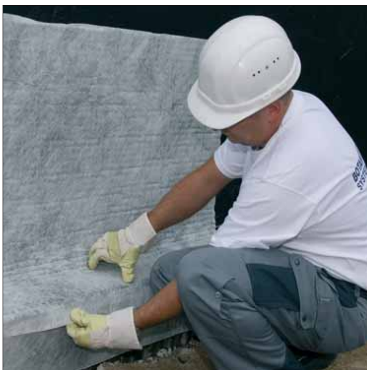
Płyta ochronno - drenażowa BOTAZIT® DS 993 chroni izolację przed uszkodzeniami mechanicznymi
