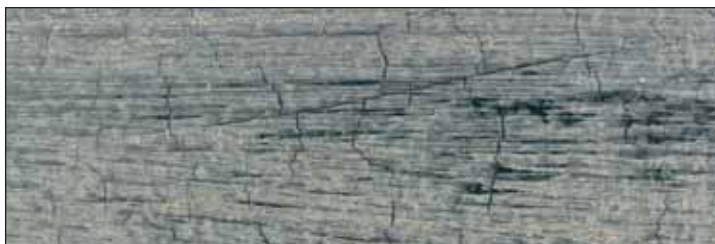
➤ Stare izolacje bitumiczne na bazie smoły
