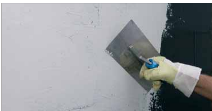
• Nanoszenie mineralnego mostka przyczepnego BOTACT® MD 28
