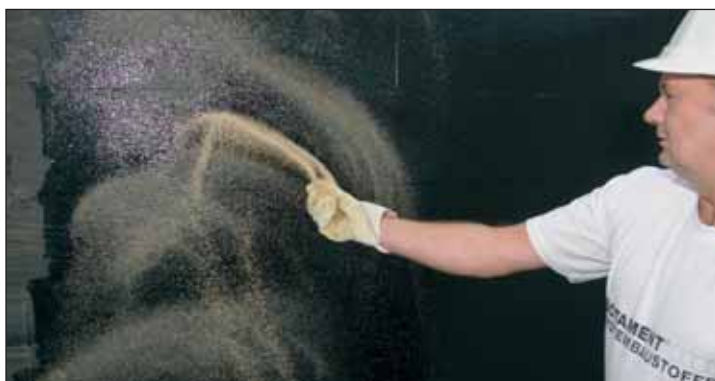
• Wykonanie posypki z suszonego piasku kwarcowego na świeżej powłoce gruntującej
