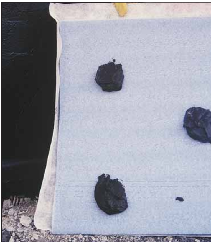
Płyta ochronno - drenażowa BOTAZIT® DS 993 chroni izolację przed uszkodzeniami mechanicznymi
