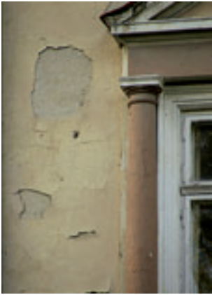
przebarwienia, złuszczenia powłok malarskich, uszkodzenia wypraw tynkarskich
