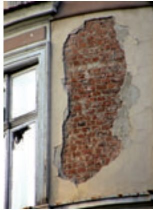
przebarwienia, złuszczenia powłok malarskich, uszkodzenia wypraw tynkarskich
