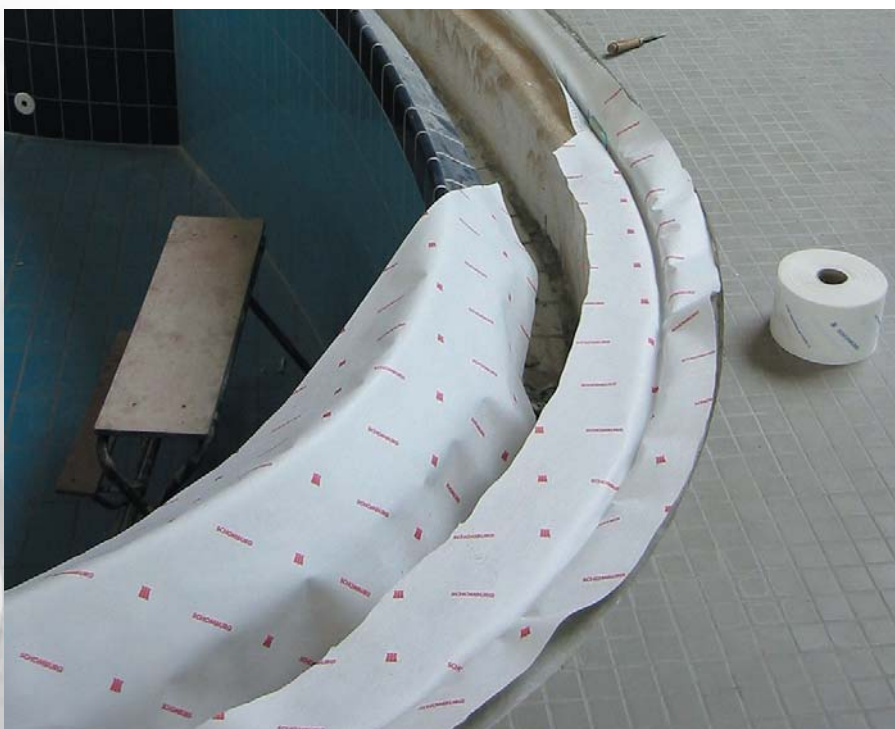
Szkody wynikające z nieszczelnej szczeliny dylatacyjnej
